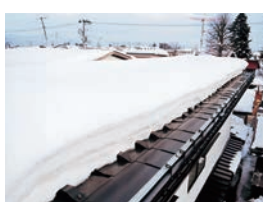
融雪屋根 設備
