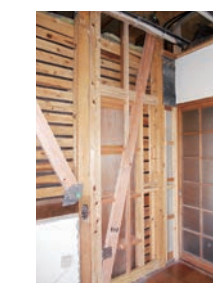
筋かいや構造用合板で補強する工事
